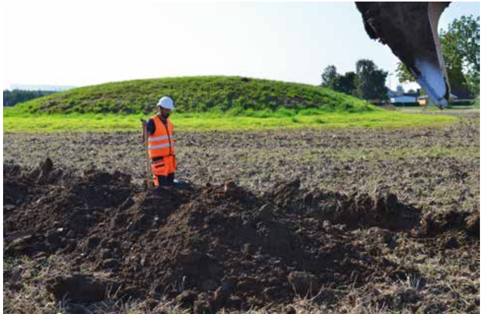
Figur 40 Schaktning invid den befintliga gravhögen i område I3. Erik Johansson följer skopan.
